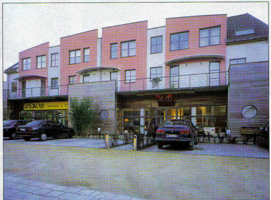
BOVEN DEZE HANDELSZAAK ZIJN OP HET EERSTE GEZICHT VIER WOONEENHEDEN ONDERGEBRACHT. IN WERKELIJKHEID ZIJN HET ER ZES. HET GEHEEL STRAAFT EEN GROTE VISUELE HARMONIE UIT, HET EIGEN KARAKTER WORDT NOG GEACENTUEERD DOOR HET MOOIE CEDERHOUT EN HET KLEURGEBRUIK.
